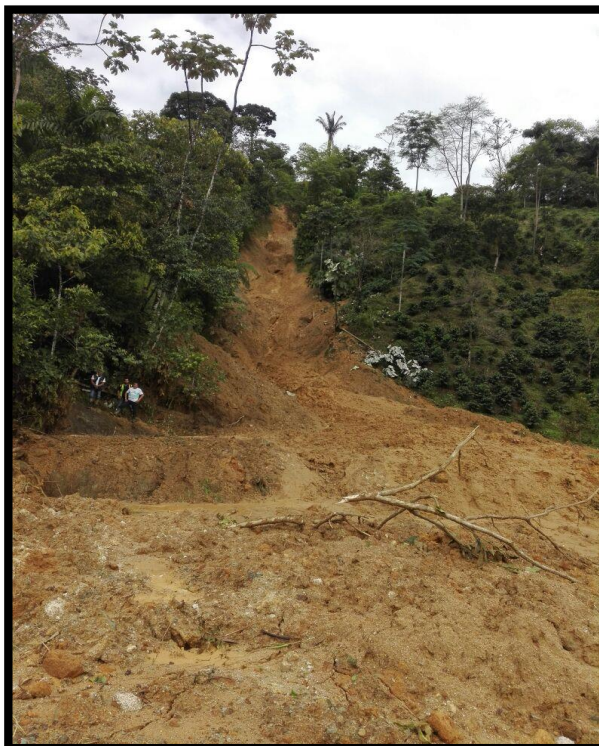
Fotografía: Deslizamiento vereda la Tebaida
